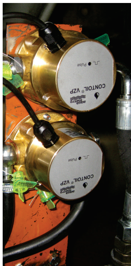
Sistem de măsurare direct, situat între tancul de consum și tancul de depozitare. Al doilea debitmetru măsoara returul injectoarelor.
