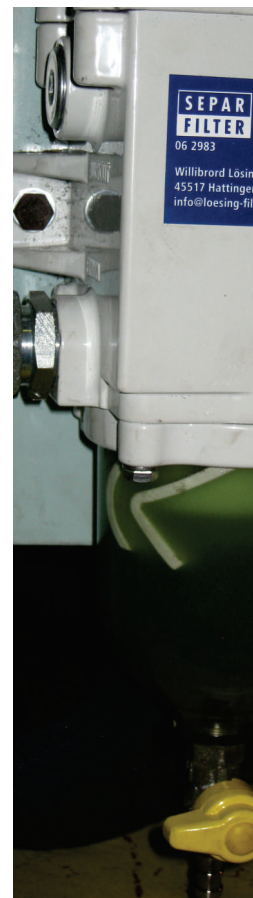
Filtru de tip SEPAR la intrarea in debitmetru
